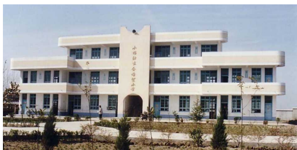
2002年着工 05年樹木も育った校舎全景
